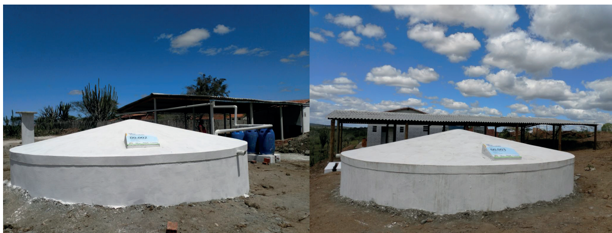
Figura 7. Aplicação do modelo de cisterna telhadão em outras comunidades: a) cisterna 002 e b) cisterna 003.
