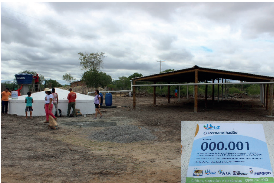
Figura 6. Primeira cisterna-telhadão construída
